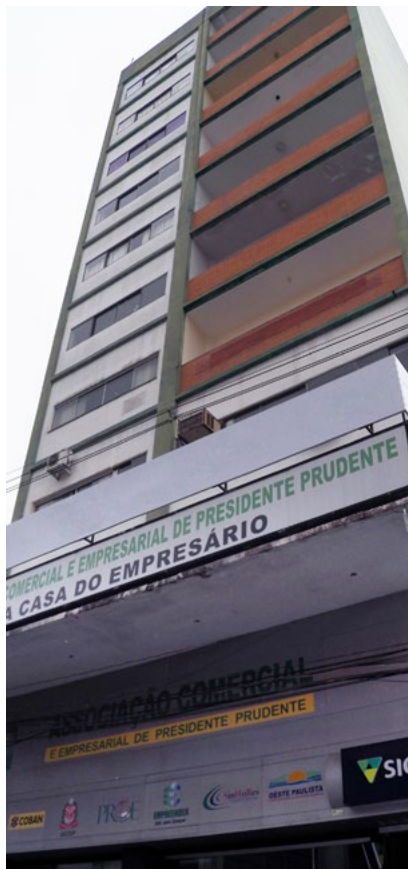
Em Prudente, três endereços: prédio da ACIPP (foto), Prudenshopping e Rua Djalma Dutra, 176
